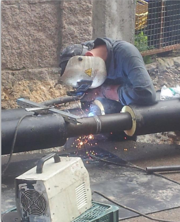
SOLDADURA DE TUBERIAS PREAISLADAS
