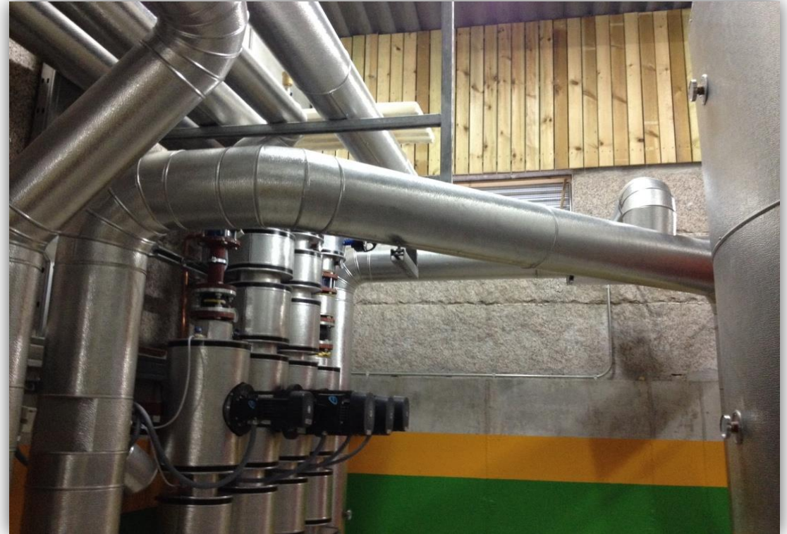
SINFINES Y COLECTORES FUNCIONANDO
