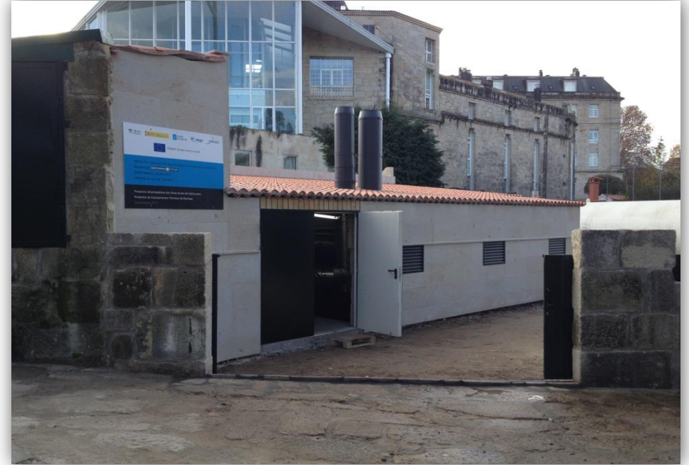
SALA DE CALDERAS VISTA TRASERA
