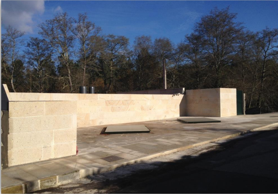
SALA DE CALDERAS VISTA CALLE
