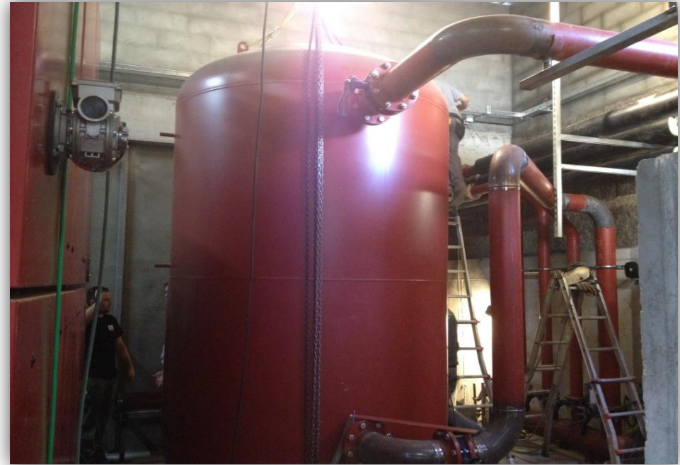
MONTAJE DEPOSITO DE INERCIA
