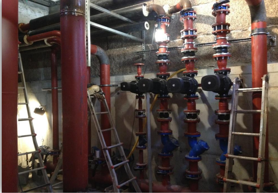
CONSTRUCCION COLECTORES
