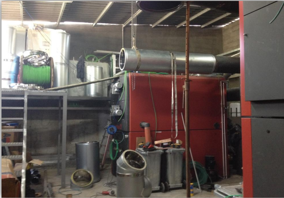
MONTAJE CALDERAS BIOMASA
