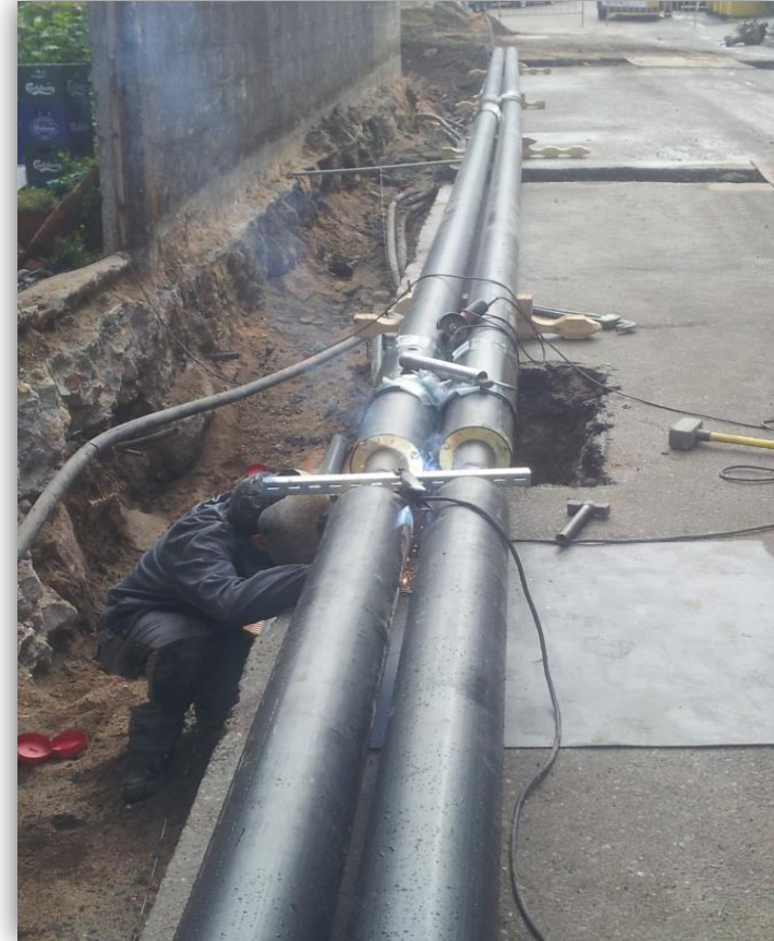
SOLDADURA DE TUBERIAS PREAISLADAS
