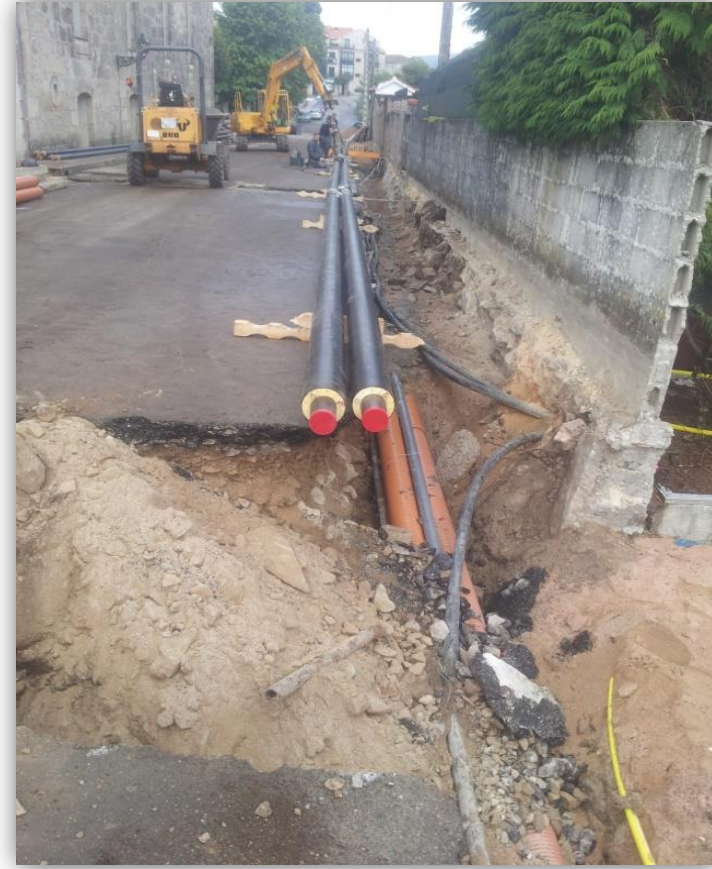
MONTAJE DE TUBERIAS POR ACERAS Y VIA PUBLICA
