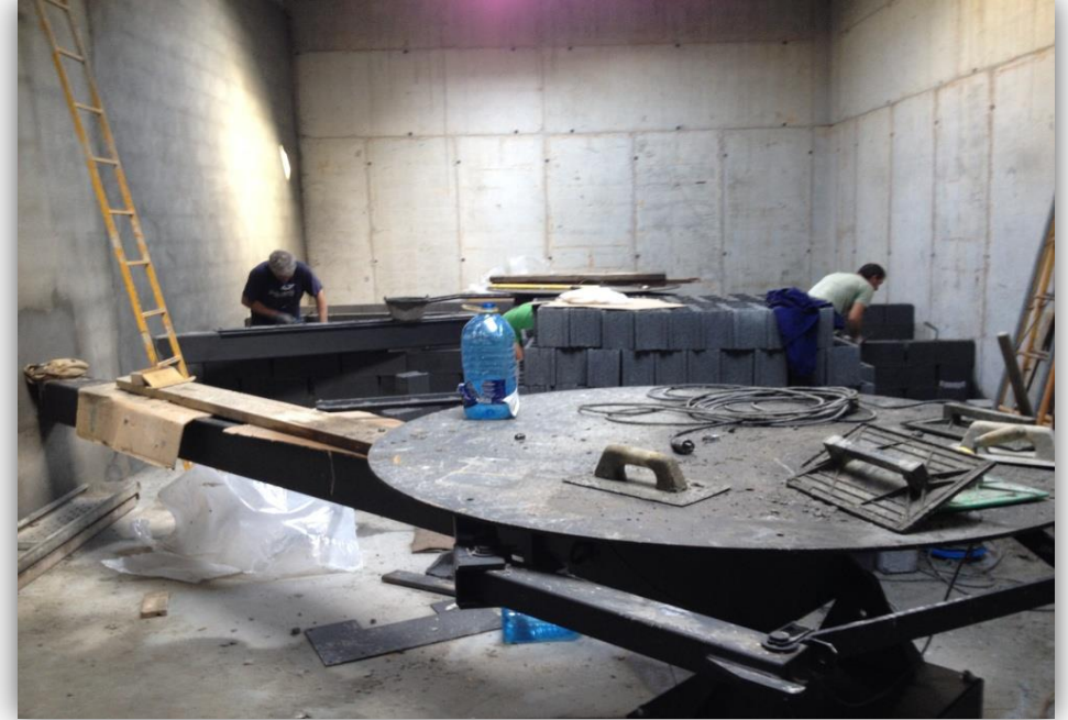
MONTAJE DE AGITADORES
